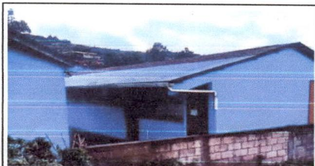
Foto 6: Tubo Bajada de Agua en mal Estado
